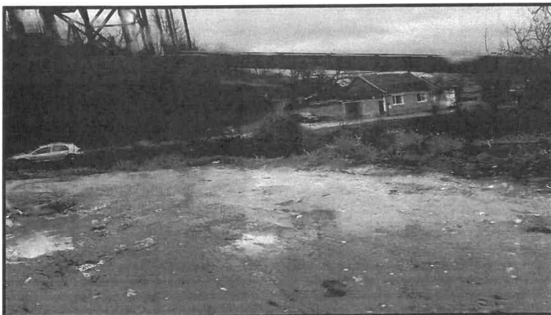
Foto 04. Situatia existenta pe strada analizata
