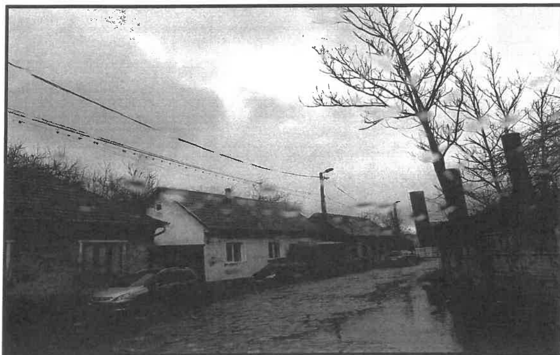
Foto 02. Situatia existenta pe strada analizata
