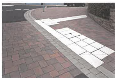
Fig. 51 - Exemplu trecere de pietoni cu marcaj tactil
