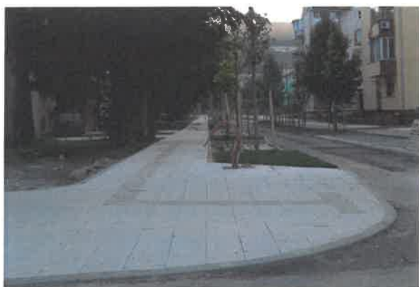
Fig. 37 - Extindere trotuar intersecție
