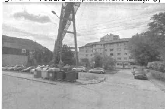
Figura 6- Vedere containere existente aferente locației 6
