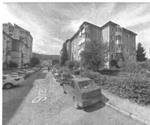
Figura 11- Vedere amplasament propus locație 11
