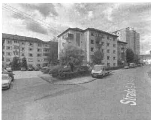
Figura 10- Vedere amplasament propus locație 10
