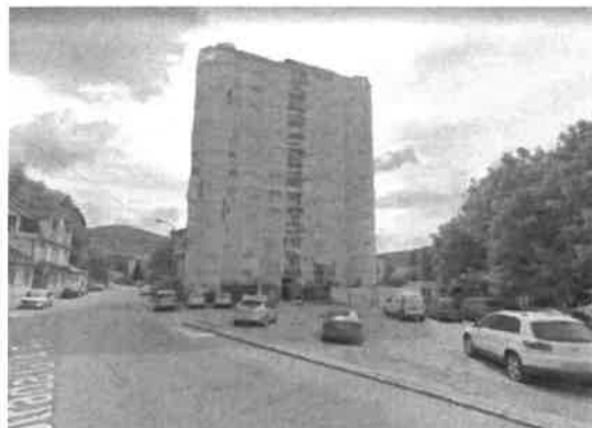
Figura 9- Vedere amplasament propus locație 9
