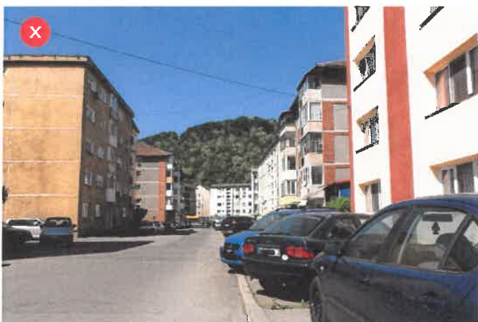
Figură 13 Situația existentă a locurilor de parcare-incorect.
