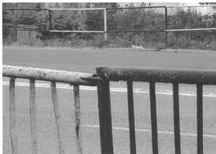
FOTO 5 - Continuizare la mâna curentă la parapet
