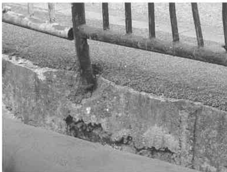
FOTO 3 - Stâlp parapet amonte
