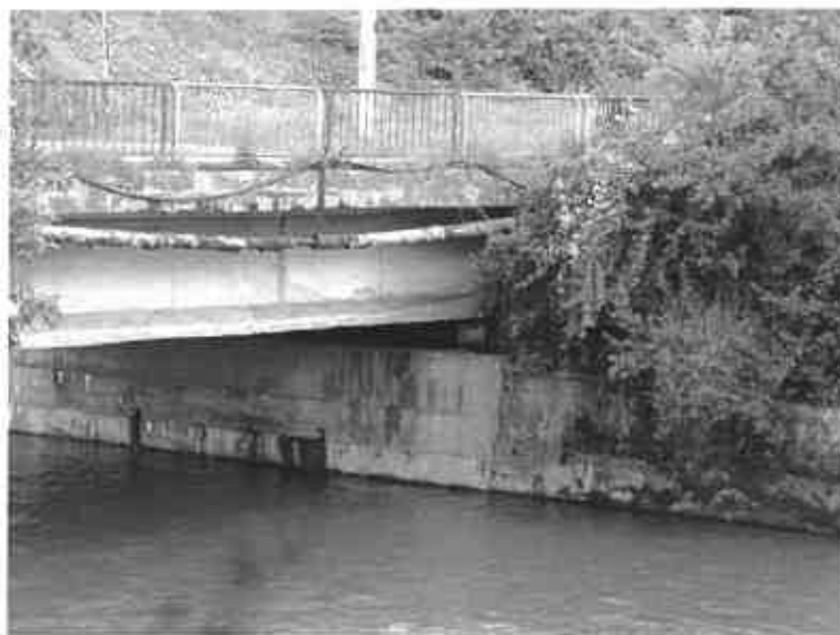
FOTO 13 - Culee mal stâng, vedere din aval
