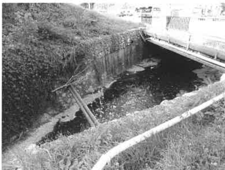
FOTO 8 - Vedere din amonte
