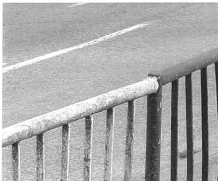
FOTO 6 - Mâna curentă la parapet
