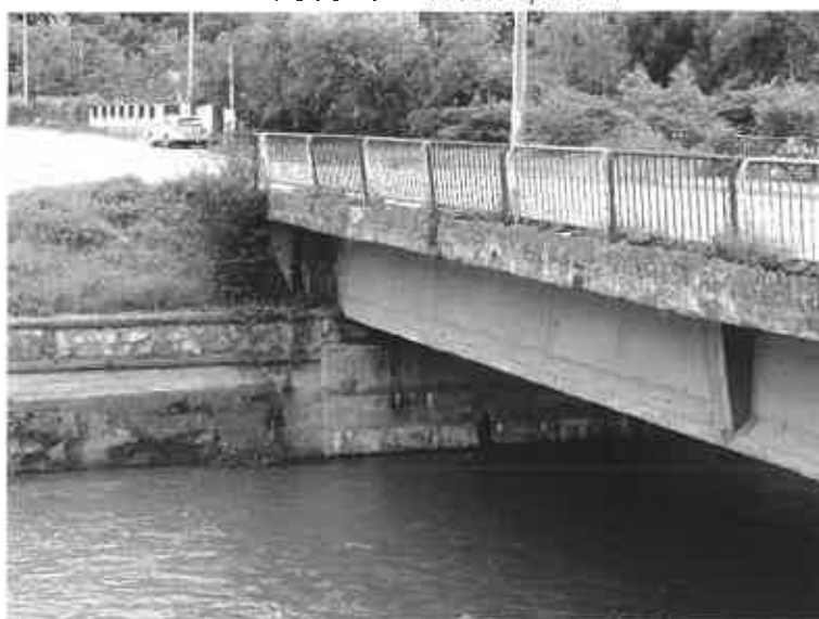
FOTO 21 - Protecție de mal stâng amonte
