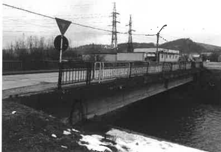
FOTO 1 - Vedere din amonte
