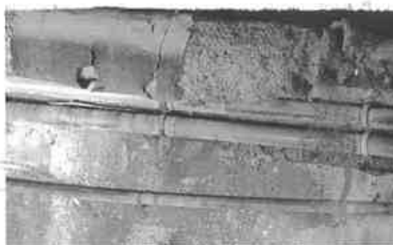
FOTO 18 - Detaliu rețele edilitare, culeea mal drept
