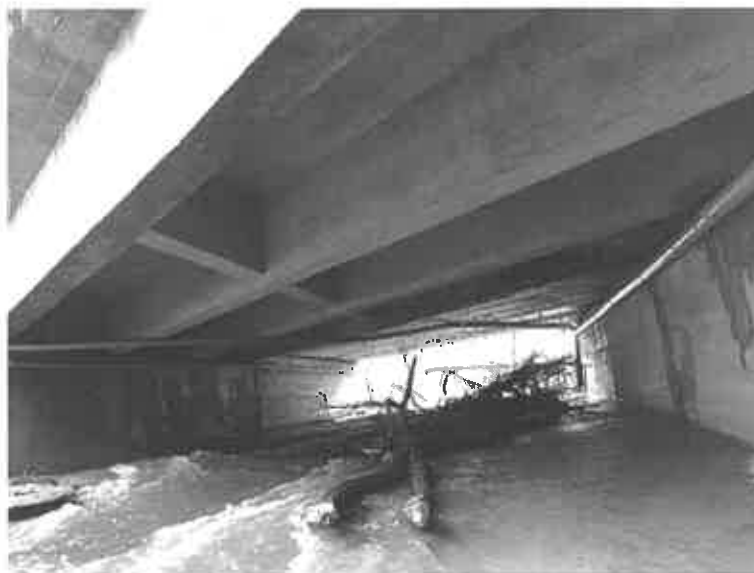
FOTO 15 - Intrados structură aval, pe grinzi
