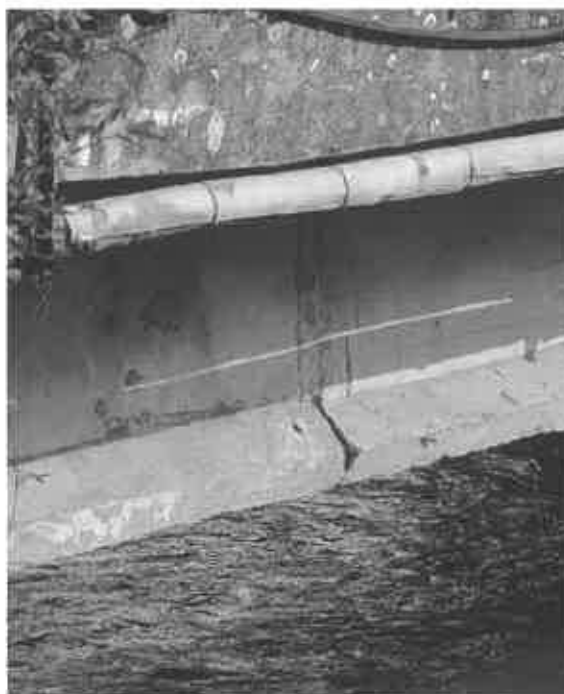
FOTO 17 - Detaliu rețele edilitare, aval
