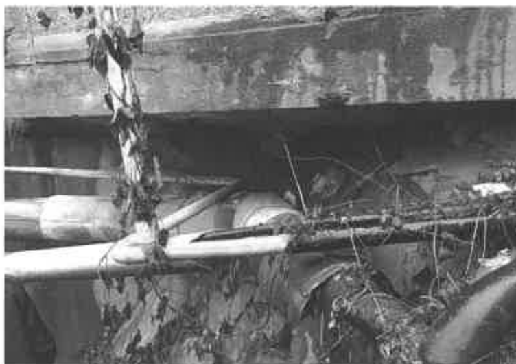
FOTO 26 - Detaliu rețele la culeea mal stâng aval
