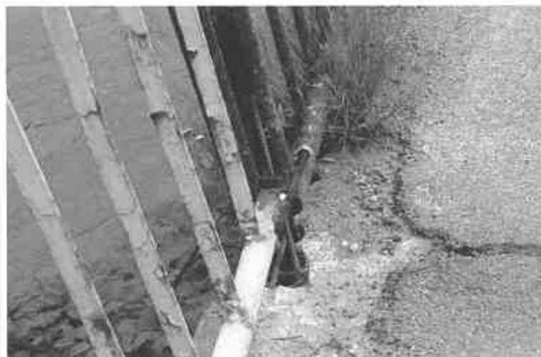
FOTO 6 - Detaliu fixare parapet pietonal
